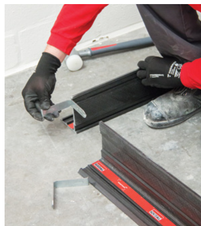
03 Coloque las uniones angulares
